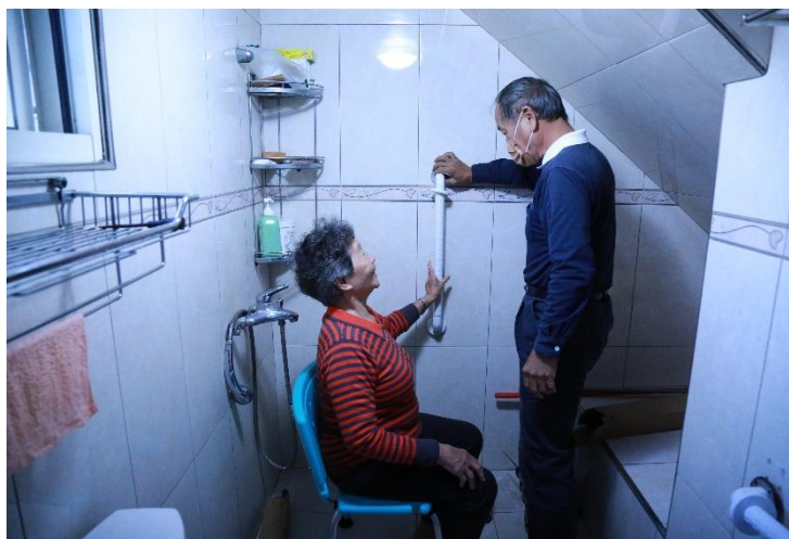
居家安全改善服務，慈濟修繕志工實際測量安裝扶手高度。2025/1/6
