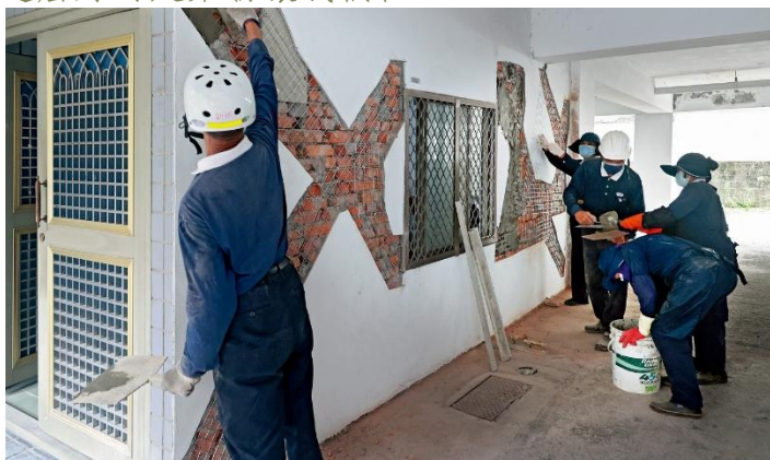
花蓮一住戶，牆壁裂開，志工將突出的地方挖掉，再用鐵絲網固定，最後上兩層水泥讓牆壁更加牢固。2024.4.22
