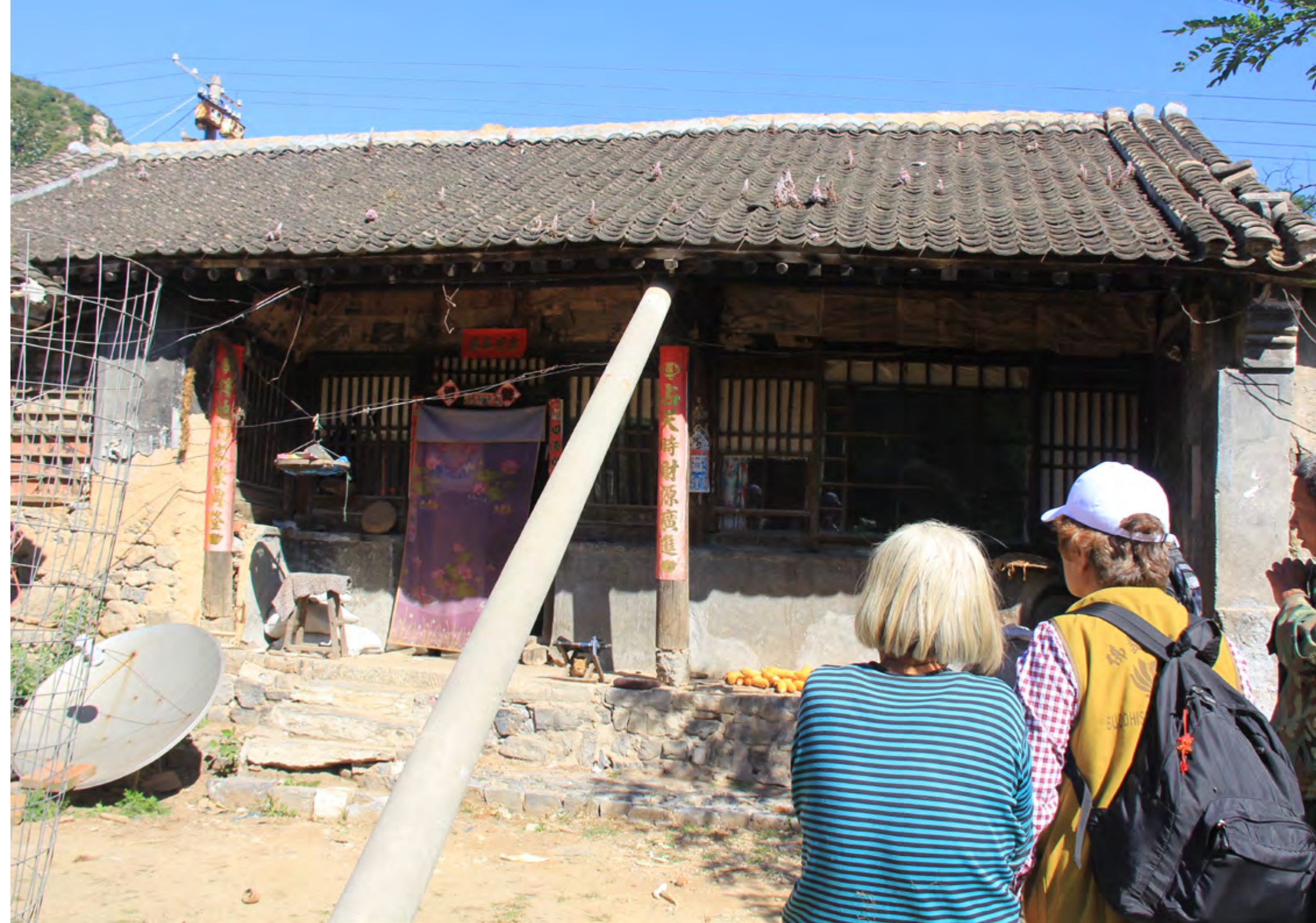
老舊的屋子靠著柱子支撐避免傾倒。 攝影 / 任琳 2012.09.15 地點 / 中國大陸河北省保定市易縣安格莊鄉
