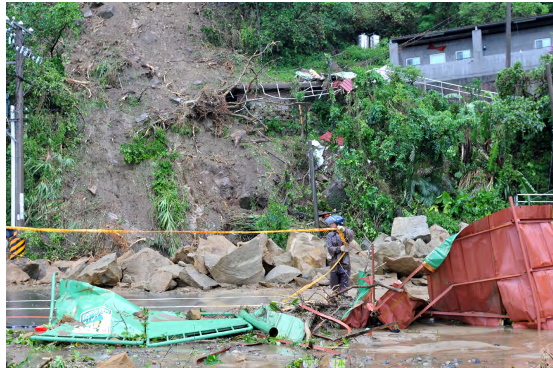
大雨不斷沖刷導致土石崩塌滑落。 攝影 / 游錫璋 地點 / 基隆市中正區 2013.09.01
