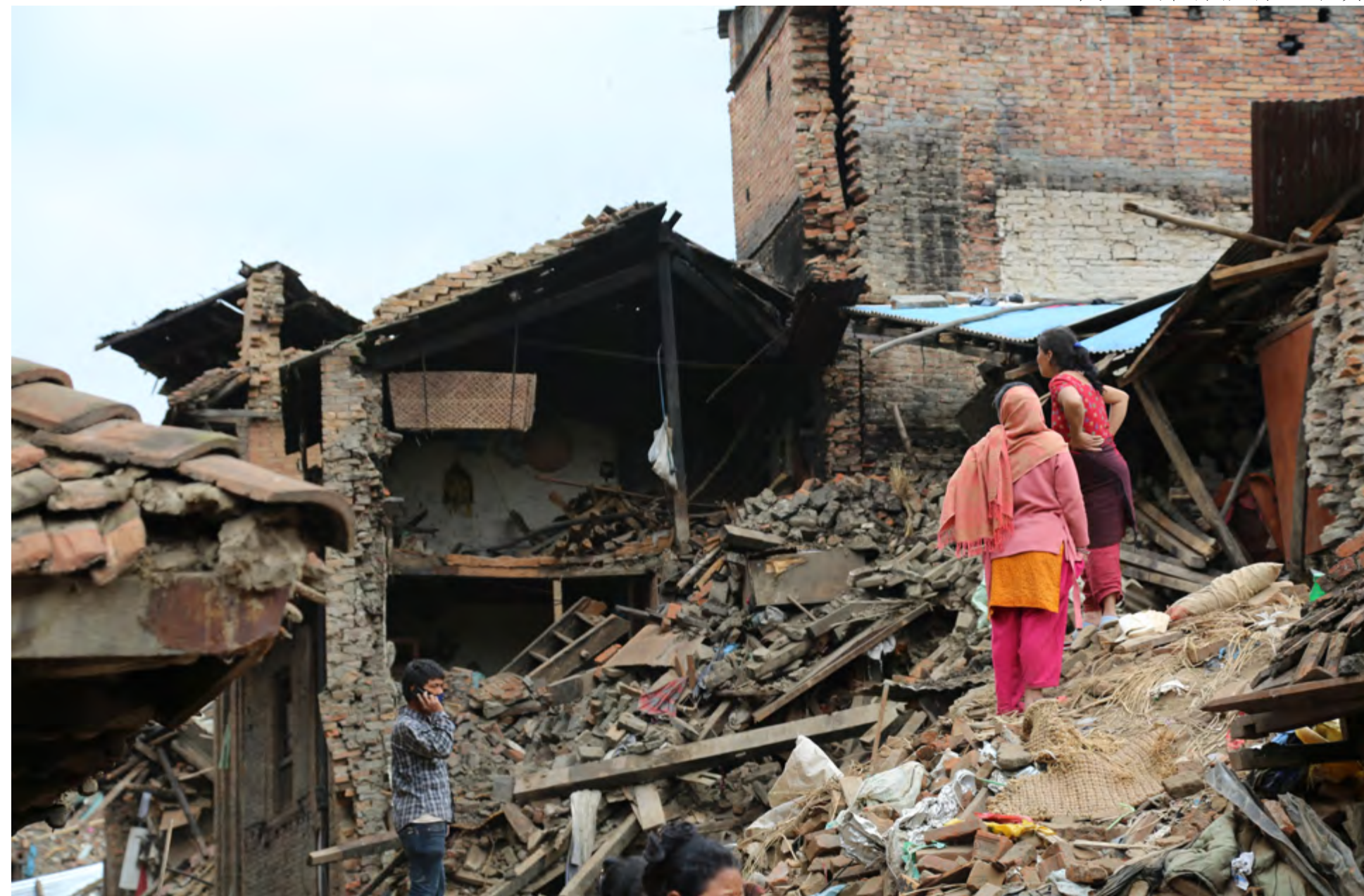
災區建築物嚴重毀損，災民無語看著破碎的家。
