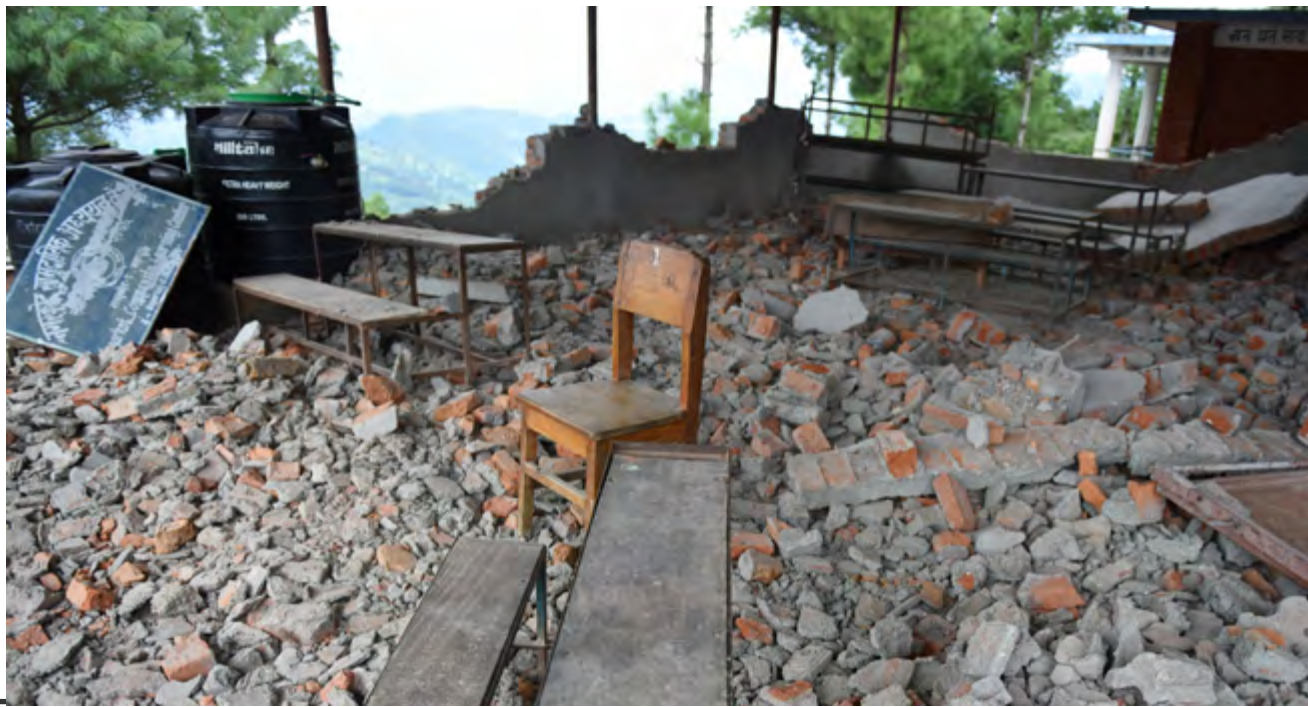
佳佳德學校建築嚴重毀損。 攝影 / 游錫璋 2015.07.27 地點 / 尼泊爾巴格馬蒂 (Bagmati) 那加闊 (Nagarkot) 佳佳德學校 (Shree Gadgade Lower Secondary School)
