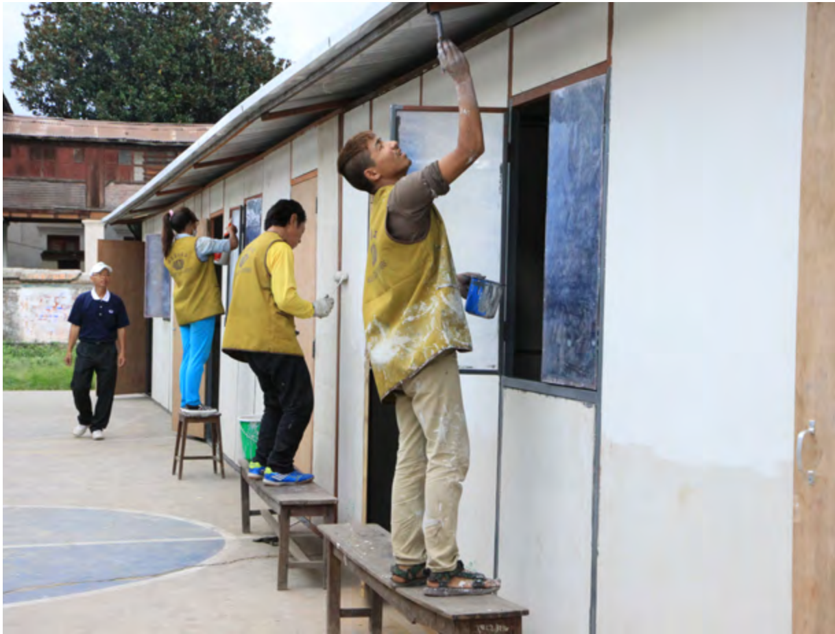
簡易教室即將完工，以工代賑鄉親用心粉刷牆壁。 攝影 / 吳碧珠 2015.07.29 地點 / 尼泊爾巴格馬蒂 (Bagmati) 拉利波爾 (Lalitpur) 特里布文大學 帕坦分校 (Tribhuvan University Patan Multiple Campus)
