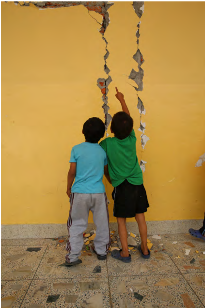
因地震造成校舍牆壁嚴重龜裂。 攝影 / 葉晉宏 2015.05.28 地點 / 尼泊爾加德滿都 (Kathmandu) 喜馬拉雅寄宿學校 (Shree Mangal Dvip Boarding School · SMD)
