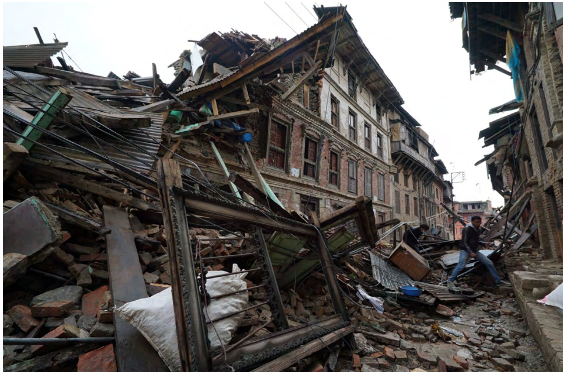
災區建築物嚴重毀損。
