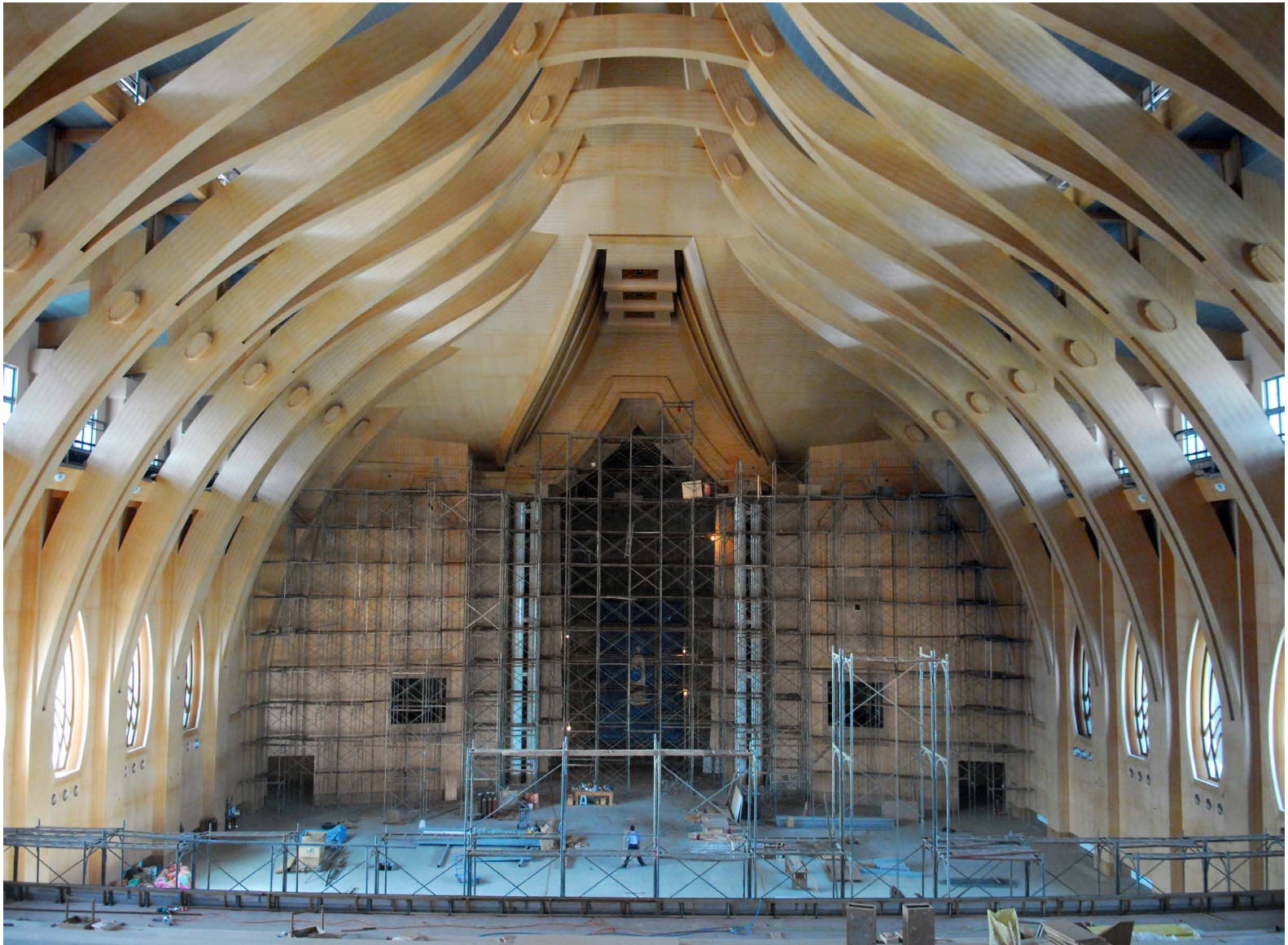
高雄靜思堂內部工程
