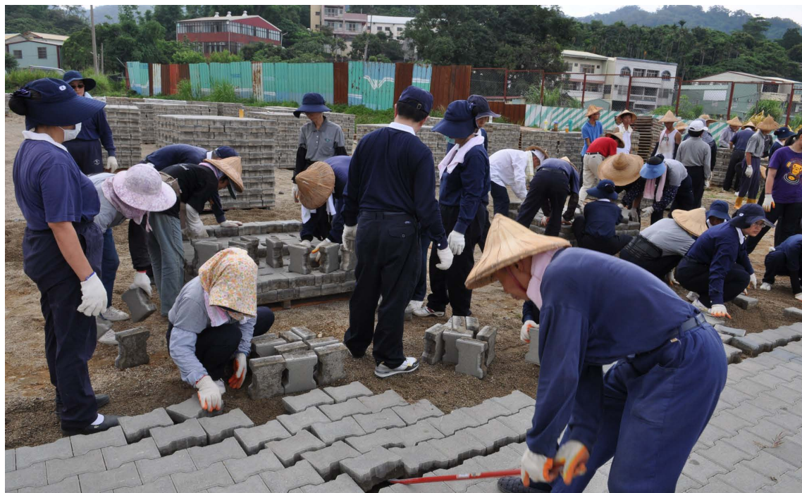
台中慈濟志業園區連鎖磚拆除工程 攝影 / 曾東勝 地點 / 台中志業園區 2011.07.07
